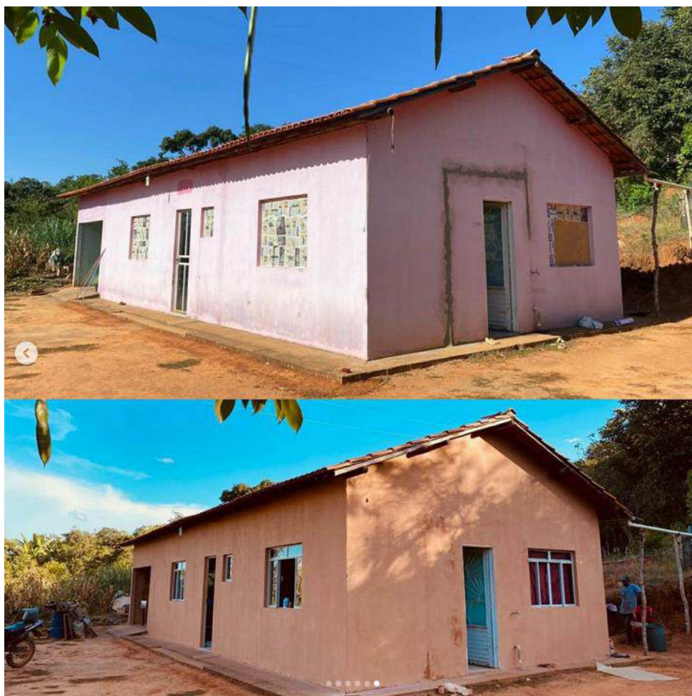
Figura 38 e 39 - Centro Comunitário = sede da Associação:
