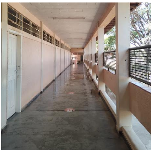
Figura 11: Corredor das salas de aula do primeiro andar, lado esquerdo
