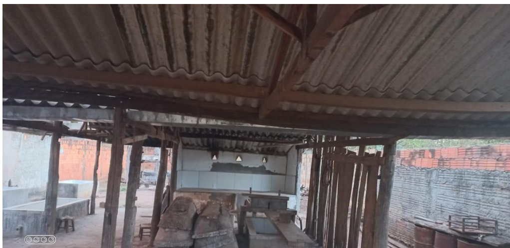
Figura 5: Foto do interior da Oficina de Cima
