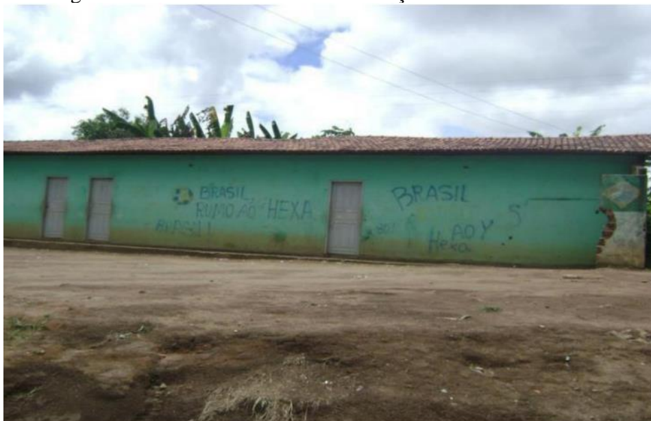
Figura 2 - Imagem da Escola Estadual Sebastião Peçanha de Oliveira antes da ampliação
