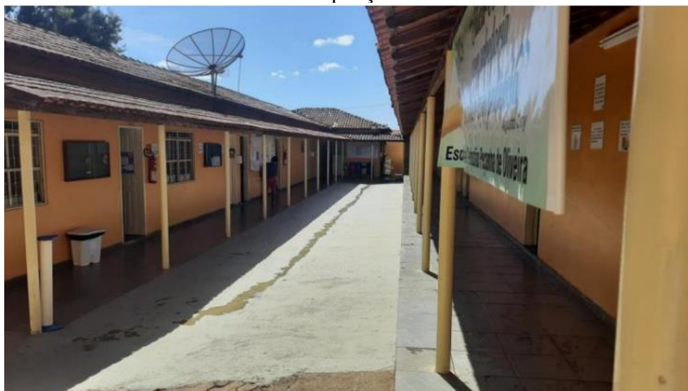
Figura 3 - Imagem da Escola Estadual Sebastião Peçanha de Oliveira após sua reforma e ampliação
